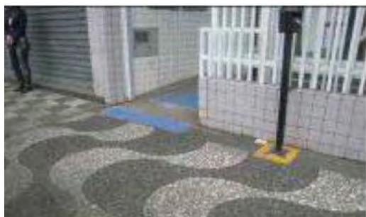
Figura 4: Portão de Entrada e Piso Sinalizado Fonte: CHEQUELEIRO, 2014.
